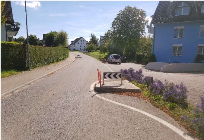
Horizontaler Versatz mit Betontrapezen
